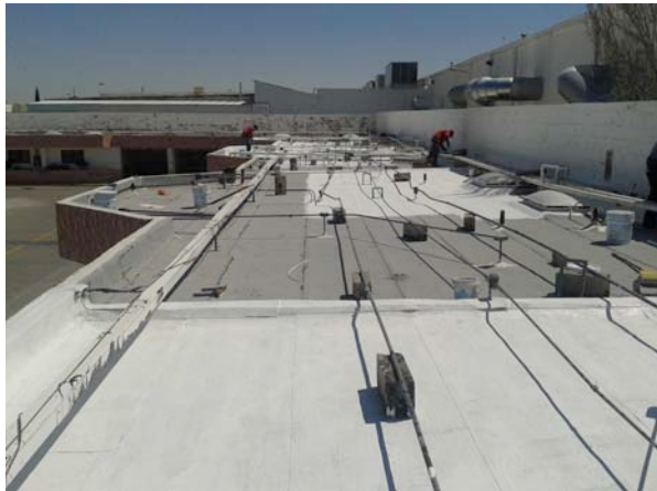
Secado primer capa para proceder a aplicar segunda capa
