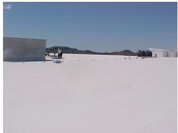
Losa impermeabilizada con SELLOFLEX THERMO
