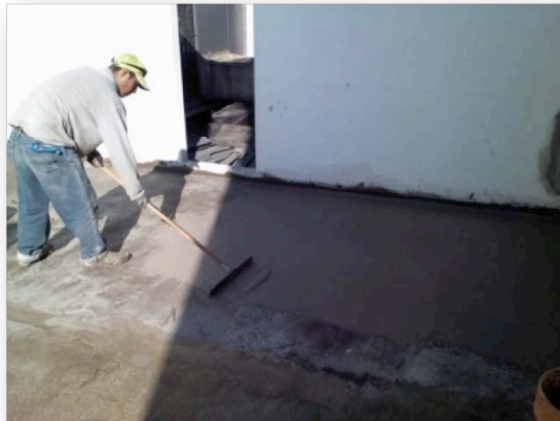
Aplicación de segunda capa de SELLOMEX LASTIC
